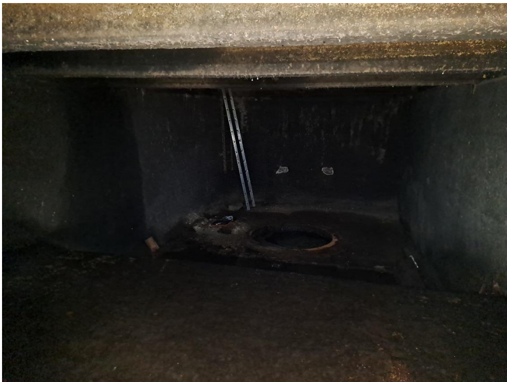
Kuva 3. Turbiinikammioiden vedeneristeestä ja tasoitteesta otettu näyte ei sisällä asbestia (näyte 4). Näytettä 4 vastaavat materiaalit voidaan PAH-pitoisuuden osalta käsitellä normaalisti.
