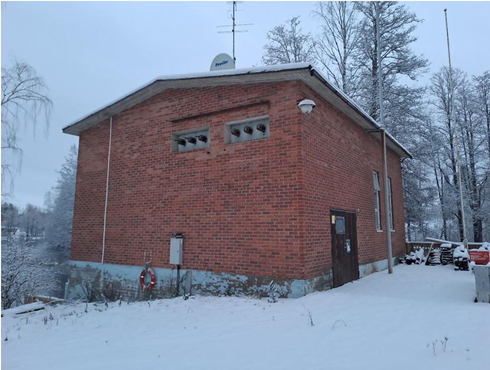
Kuva 13. Voimalaitos on tiili / betonirakenteinen. Voimalaitoksen rakenteissa ei havaittu asbestipitoisia materiaaleja.
