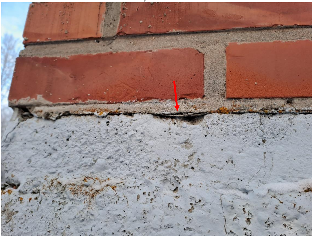
Kuva 6. Sokkelikaistan huovasta ja bitumista otettu näyte ei sisällä asbestia (näyte 6). Näytettä 6 vastaavat materiaalit voidaan PAH-pitoisuuden osalta käsitellä normaalisti.
