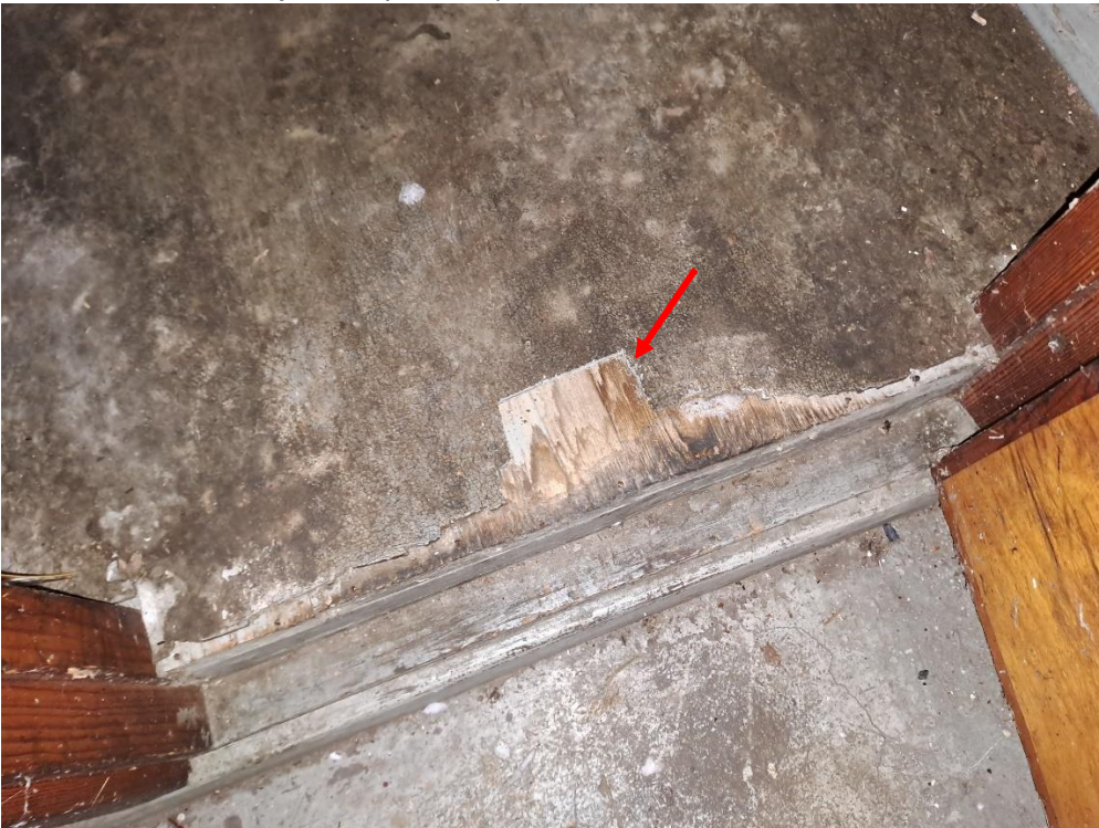
Kuva 2. Valvojankopin lattian muovimatosta otettu näyte ei sisällä asbestia (näyte 3).
