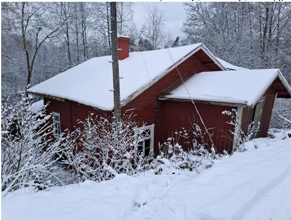
Kuva 12. Meijerirakennus on pääosin puurakenteinen eikä rakennuksen rakenteissa havaittu asbestipitoisia materiaaleja.
