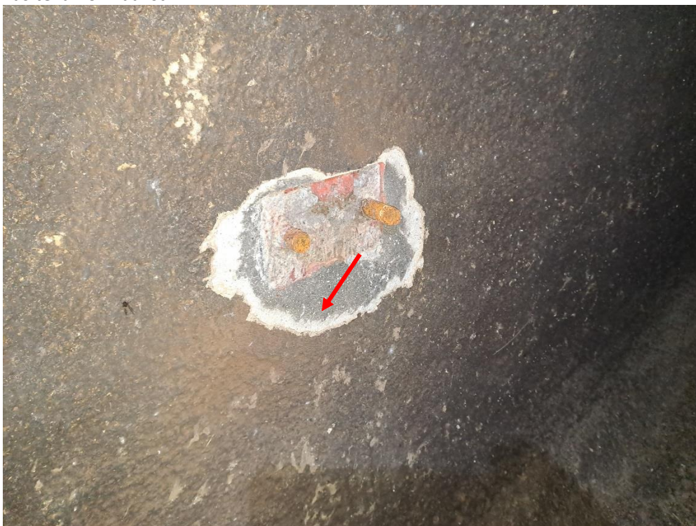
Kuva 4. Turbiinikammioiden vedeneristeestä ja tasoitteesta otettu näyte ei sisällä asbestia (näyte 4). Näytettä 4 vastaavat materiaalit voidaan PAH-pitoisuuden osalta käsitellä normaalisti.
