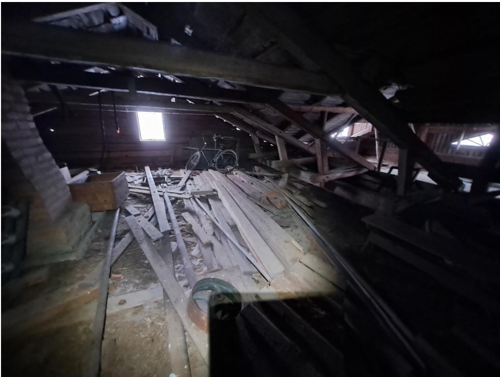
Kuva 10. Meijerin yläpohjan tervapaperista otettu näyte ei sisällä asbestia (näyte10). Näytettä 10 vastaavat materiaalit tulee käsitellä RATU-kortissa 82-0381 kuvattujen ohjeiden mukaan. Purkujäte on käsiteltävä ja hävitettävä vaarallisena jätteenä.
