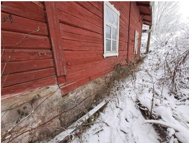
Kuva 1 Kuva rakennuksen sokkelirakenteesta yläjuoksun puoleiselta päädyltä.
