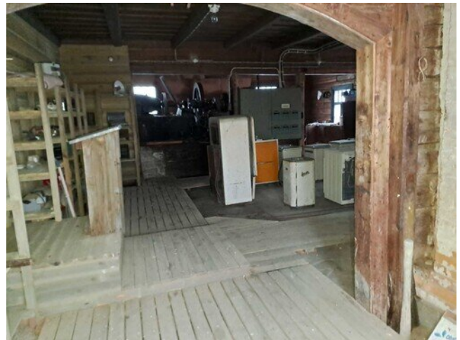
Kuva 42 Kuva aulatilasta. Aulan seinien ja laipion hirsi- ja puupinnat ovat pääosin puhtaalla puupinnalla ja ovat kohtalaisessa kunnossa.
