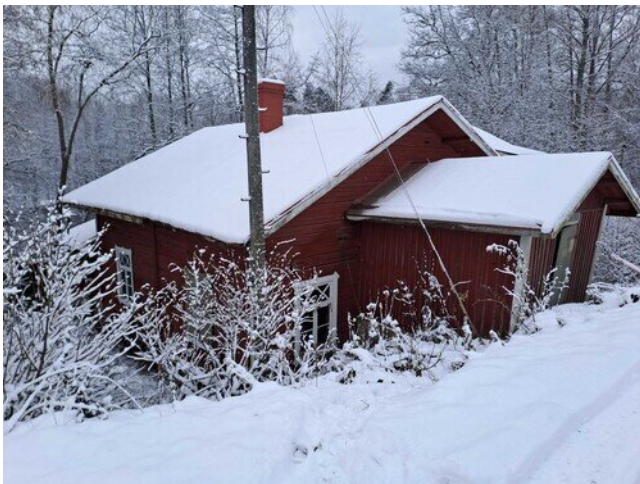
Kuva 31 Rakennuksen vesikattona on peltikatteinen harjakatto. Vesikatteen kuntoa ei päästy tarkastamaan lumipeitteen johdosta.
