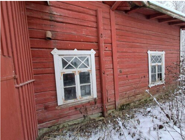
Kuva 5 Rakennuksen tien puoleisella sivulla maanpinta on osittain sokkelirakennetta korkeammalla hirsi- ja puurakenteiden tasolla.
