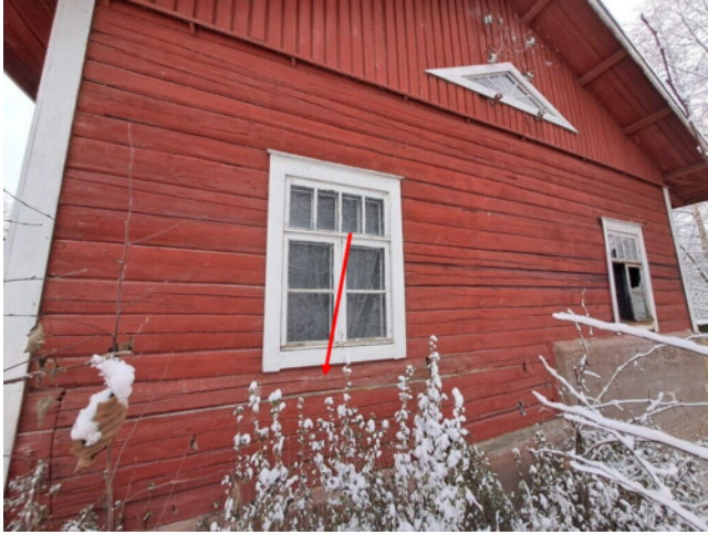
Kuva 19 Alajuoksun puoleisessa päädyssä ei havaittu merkittäviä lahovaurioita. Ikkunan alapuolelta hirsiseinä on hieman pullistunut.
