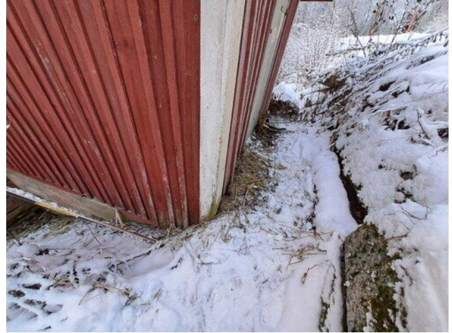
Kuva 4 Kuva sisäänkäynnin kohdalta. Rakennuksen tien puoleisella sivulla maanpinta on osittain sokkelirakennetta korkeammalla hirsi- ja puurakenteiden tasolla.
