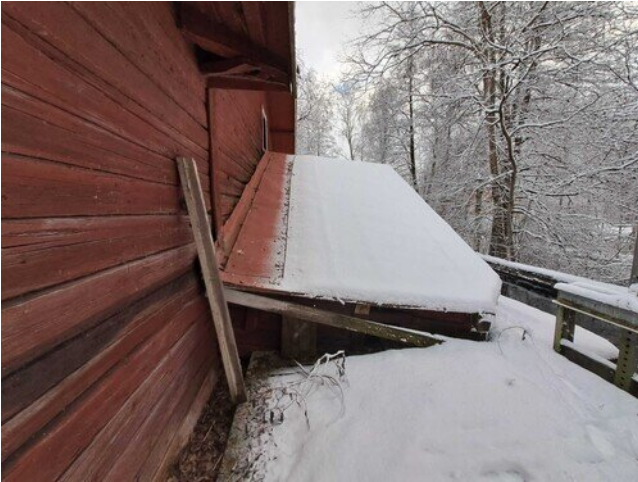
Kuva 26 Julkisivua kosken puoleiselta sivulta.
