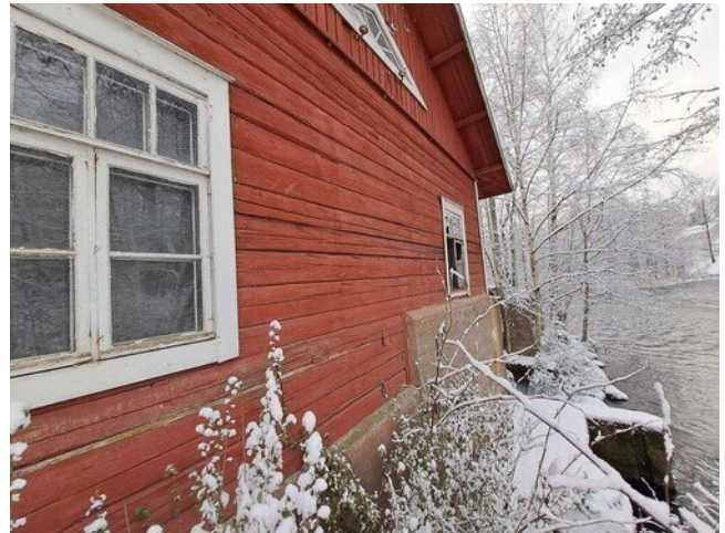
Kuva 6 Rakennuksen alajuoksun puoleisen päädyn sokkeli on betonirakenteinen. Alajuoksun puoleisen päädyn sokkelirakenteessa ei havaittu merkittäviä vaurioita, niiltä osin kun päästiin tarkastamaan.
