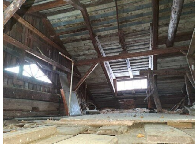
Kuva 34 Rakennuksen yläpohja on puurakenteinen. Yläpohjan puurakenteissa ei havaittu merkittäviä lahovaurioita.
