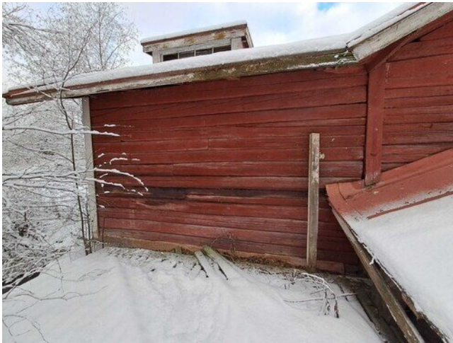
Kuva 21 Kosken puoleisella sivulla ei havaittu lahovaurioita niiltä osin kun pystyttiin tarkastamaan.
