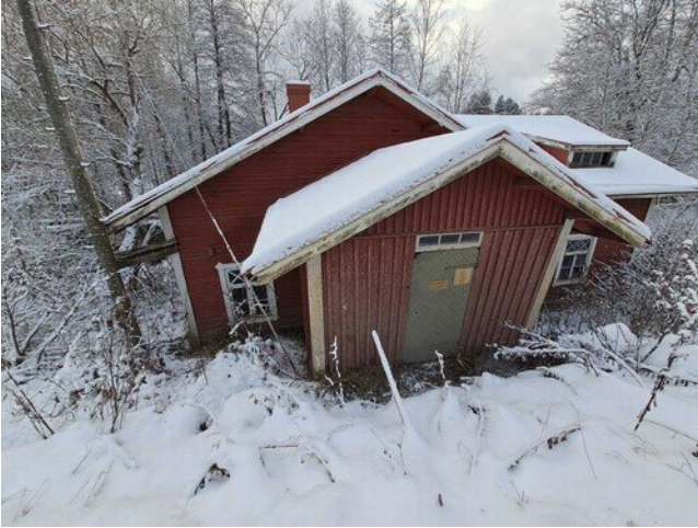
Kuva 27 Rakennuksen ulko-ovi on 1-lehtinen puuovi. Oven tarkka asennusvuosi ei ole tiedossa.
