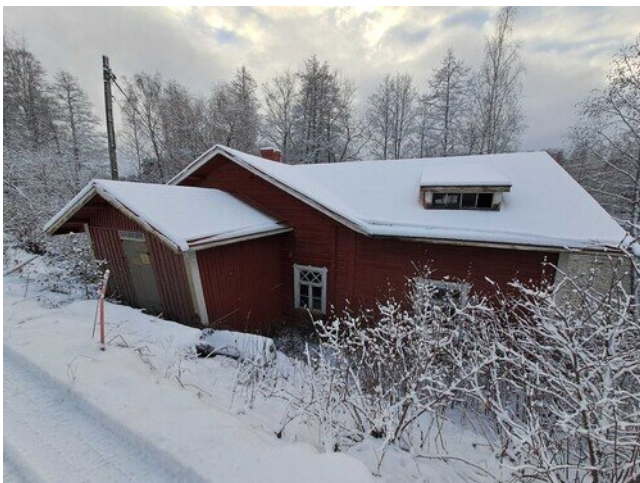
Kuva 24 Julkisivua tien puoleiselta sivulta.
