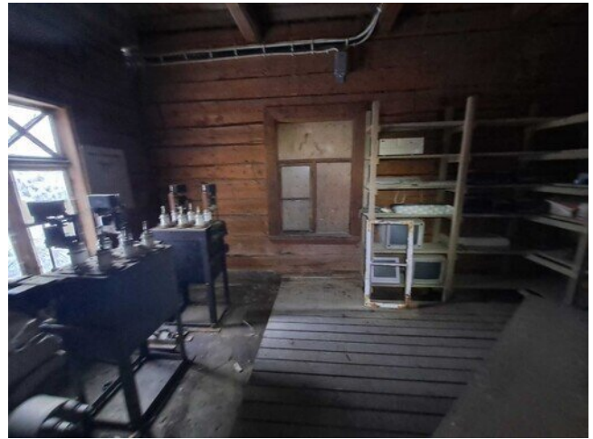
Kuva 44 Kuva huonetilasta. Huoneen seinien ja laipion hirsijä puupinnat ovat pääosin puhtaalla puupinnalla ja ovat kohtalaisessa kunnossa.
