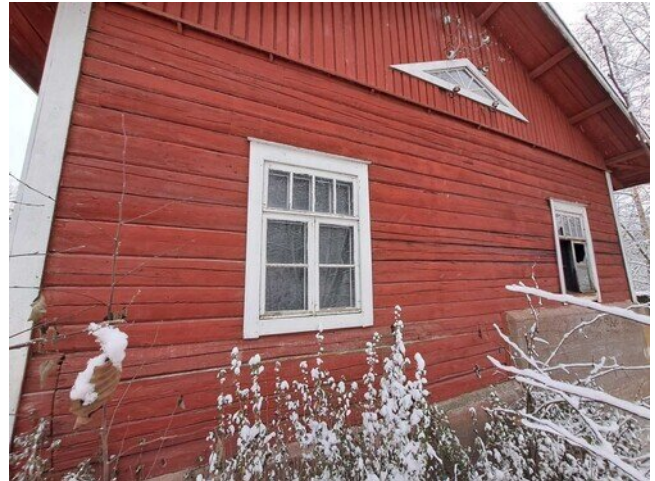
Kuva 23 Julkisivua alajuoksun puoleista pääsystä.
