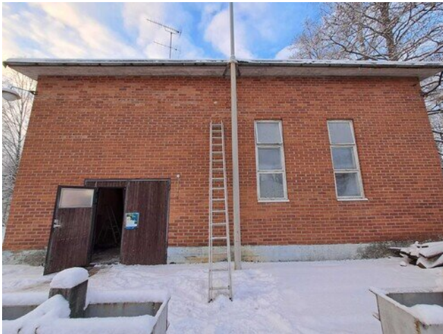
Kuva 18 Julkisivua yläjuoksun puolelta.
