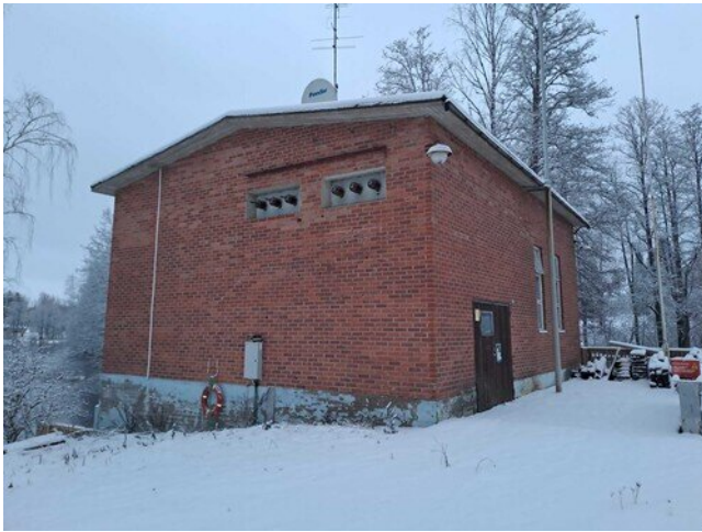
Kuva 14 Rakennuksen runko on päällisin puolin hyvässä kunnossa eikä siinä havaittu merkittäviä vaurioita.
