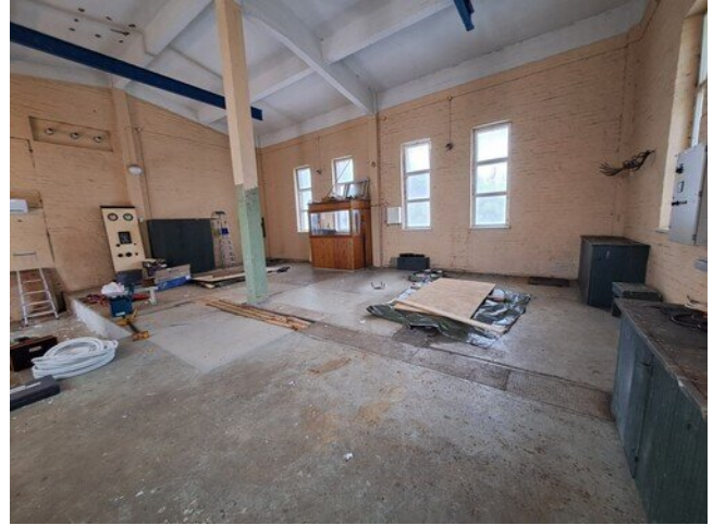
Kuva 10 Kuva turbiinisalista. Välipohjan betonilaatta on maalatulla betonipinnalla ja se on kohtalaisessa kunnossa.
