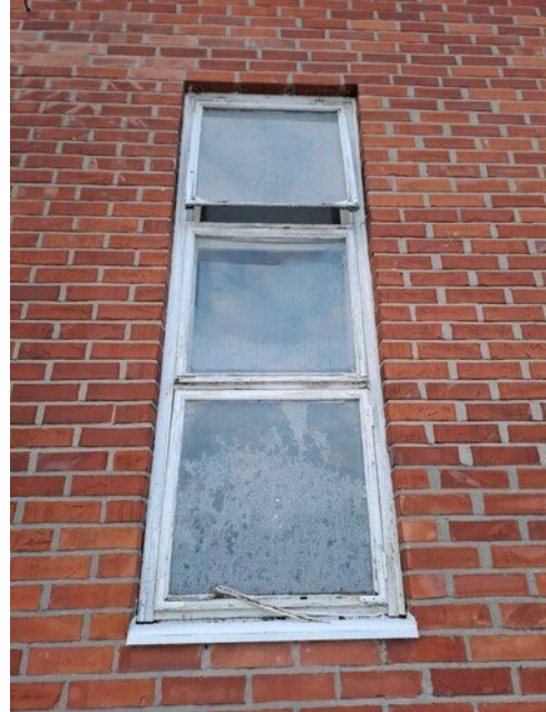
Kuva 23 Kuva rakennuksen ikkunasta.
