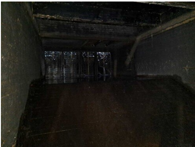
Kuva 7 Kuva turbiinikammioista. Turbiinikammion lattian (alapohjan) betonilaatta on päällisin puolin kohtalaisessa kunnossa. Turbiinikammioiden alapohjarakenne on suositeltavaa tutkia tarkemmin kun pato on purettu pois ja kammioihin ei pääse enää valumaan vettä.
