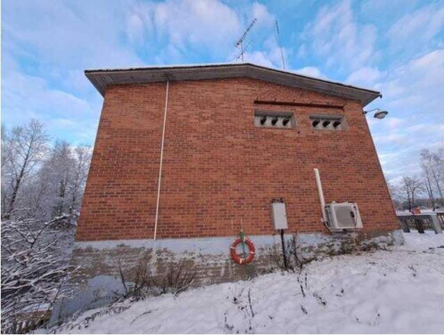
Kuva 20 Julkisivua pihan puolelta.
