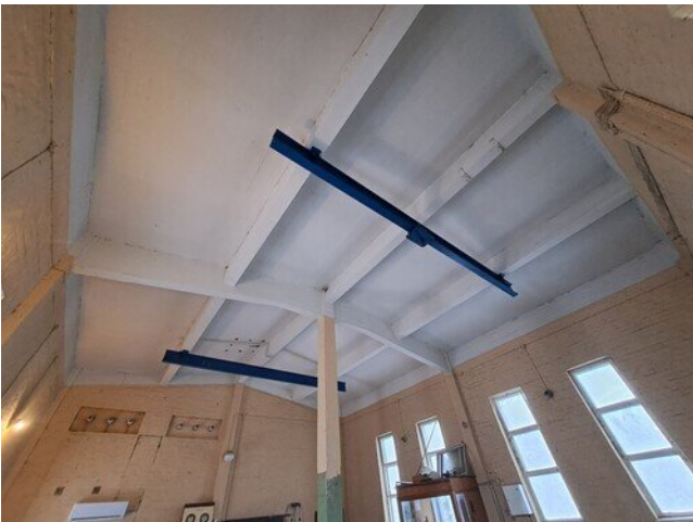
Kuva 26 Rakennuksen sisäpuolella kattorakenteissa ei ole havaittavissa kosteuden aiheuttamia jälkiä.
