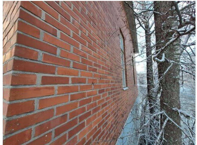
Kuva 19 Julkisivua kosken puolelta.
