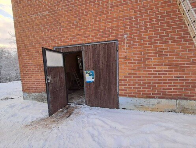
Kuva 22 Kuva rakennuksen ulko-ovesta.
