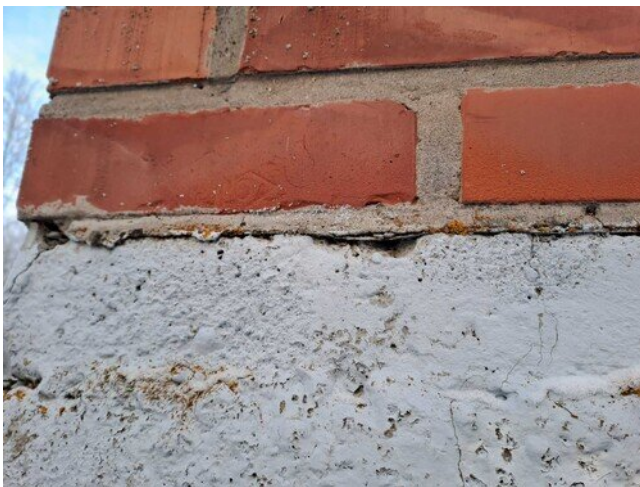
Kuva 16 Sokkelirakenteen ja tiiliverhouksen välissä on kapilaarikatkona huopakaistale.
