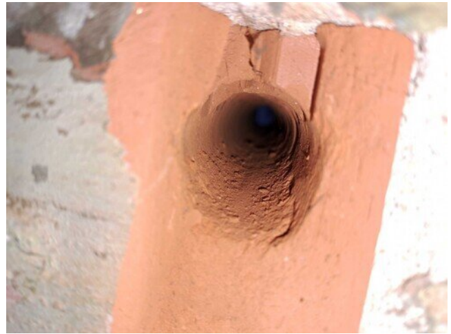
Kuva 15 Seinärakenteen paksuus seinässä olleen porareian kohdalla on noin 420 mm.
