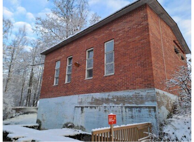
Kuva 21 Julkisivua alajuoksun puolelta.
